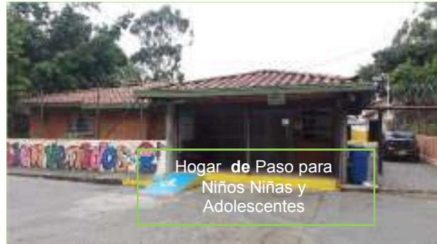
Este hogar de paso se encuentra ubicado en las coordenadas  $6^{\circ}15'48,2''N75^{\circ}34'54,4''W$ , el cual está construido con ladrillos de barro cocido y techo en teja de barro con canaleta de aluminio para el manejo de agua lluvia y cercada por una malla eslabonada, con un parqueadero y retorno en concreto que cuenta con dos canales para el manejo de las aguas lluvias justo antes de conectar con la vía para el acceso vehicular de la carrera 65 sin manejo de agua lluvia.
