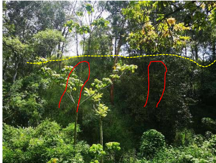
Fotografía 11 Cicatrices de deslizamiento y escarpes erosivos identificados en el cañón de la quebrada Santa Ana.
