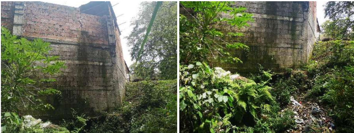
Fotografía 16 y Fotografía 17 Vivienda construida sobre el cauce de la quebrada.
