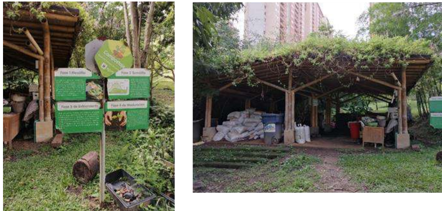
Fotografía 43 y Fotografía 44 Instalación compostera
