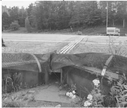
Túnel de superficie con cercado en ambos contados de la vía
