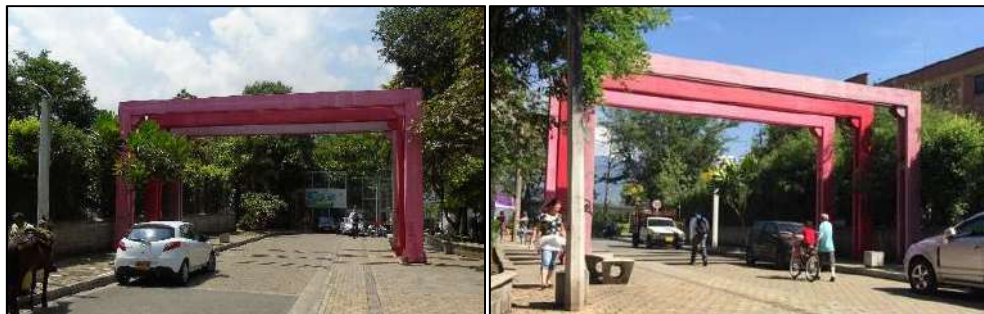
Estructura Portal de Acceso al APU – ARUCA, sector del barrio Las Palmas. Fuente: Convenio de Asociación 1087 de 2016.
