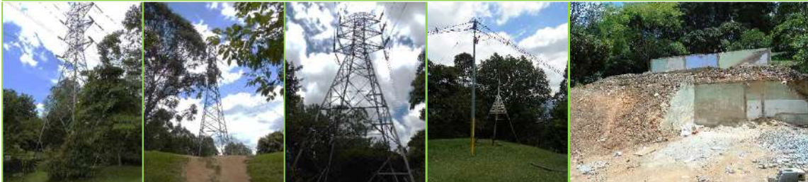
Torres de energía
