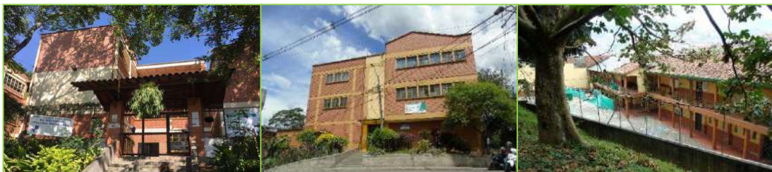
Instituciones Educativas El Salvador (izquierda), Ana de Castrillón (centro) y José de San Martín (derecha)
