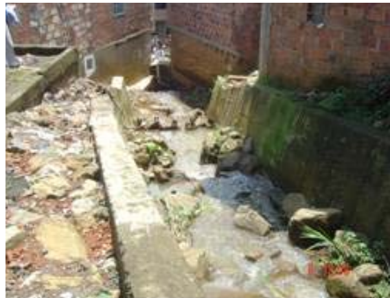
Foto A2.2. Cauce Quebrada La Rosa
