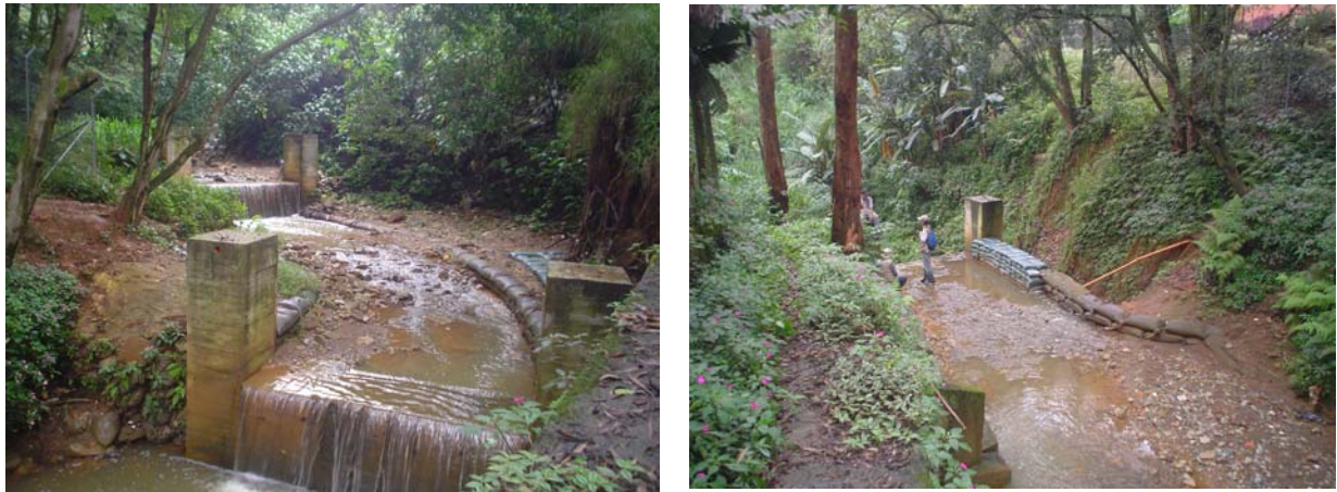
Foto A2.1. Obras hidráulicas sobre cauce natural. Quebrada la Presidenta
