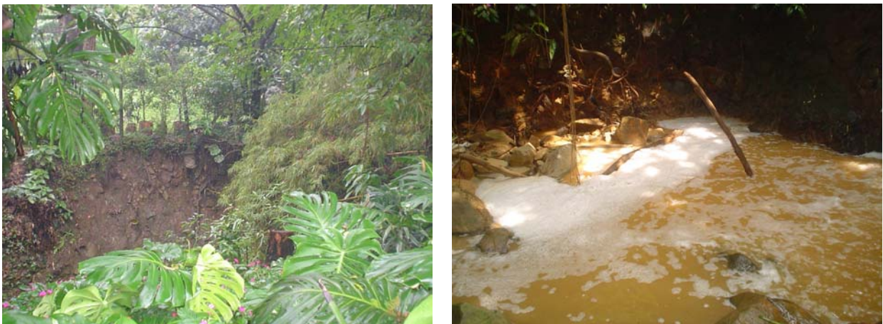
Foto A2.7. Zonas de desprendimiento de material. Quebrada la Presidenta
