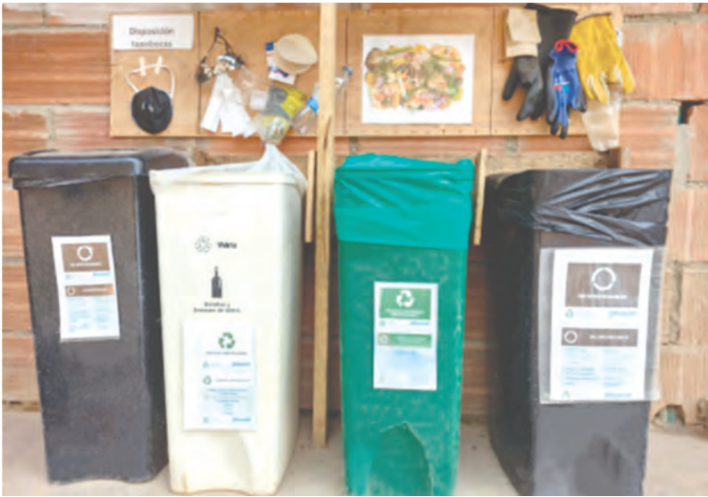
Fotografía 1. Contenedores para la clasificación de residuos en obra, indicando de manera lúdica los residuos permitidos a disponer en cada uno.
