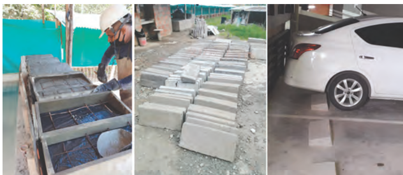
Fotografía 12. Fabricación de Topellantas, almacenamiento e instalación.
