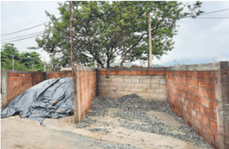
Fotografía 7. Ejemplo de almacenamiento de materiales de construcción con su canalización de agua.
