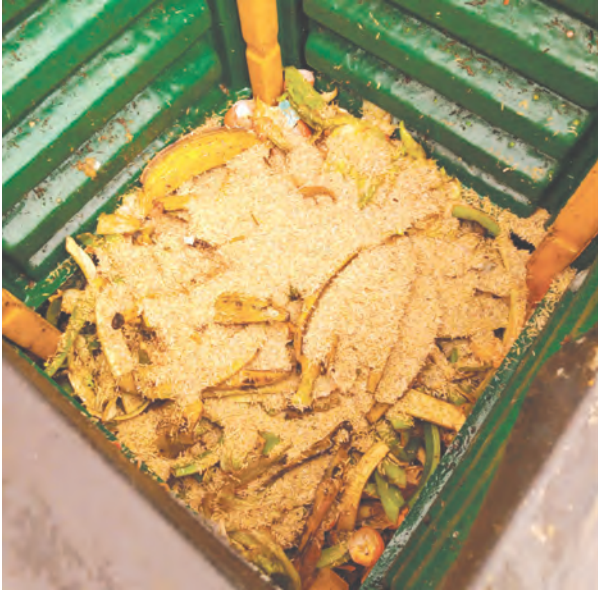
Fotografía 2. Compostaje del material orgánico en obra.
