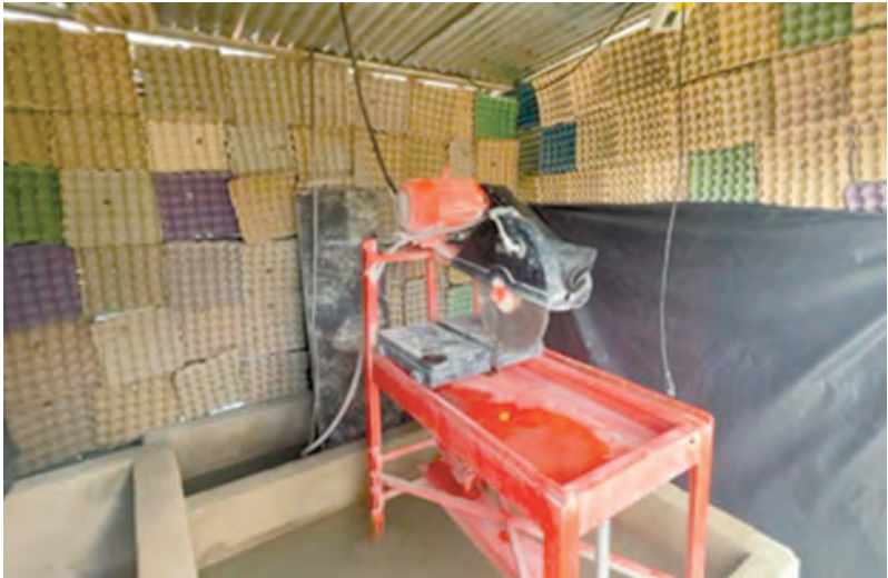
Fotografía 13. Ejemplo de cerramiento para cortadora.
