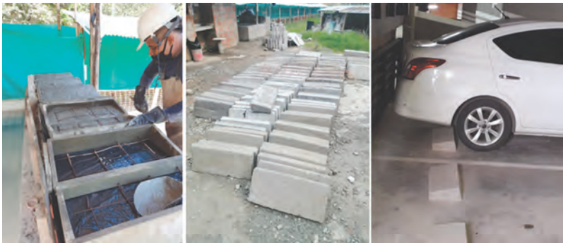
Fotografía 12. Fabricación de Topellantas, almacenamiento e instalación.
