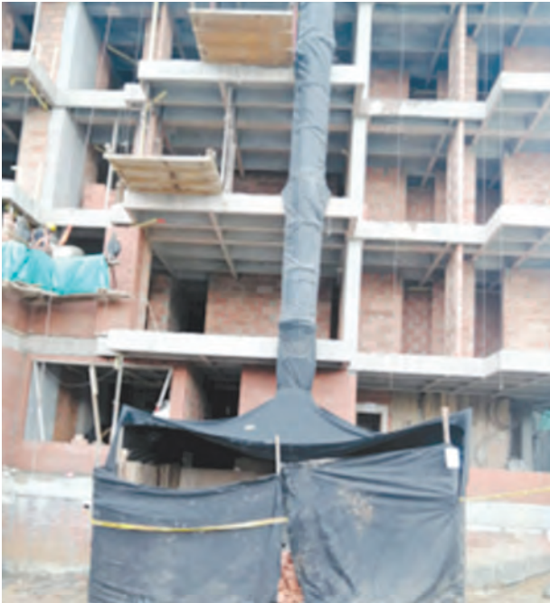
Fotografía 9. Medida para el control de material particulado.
