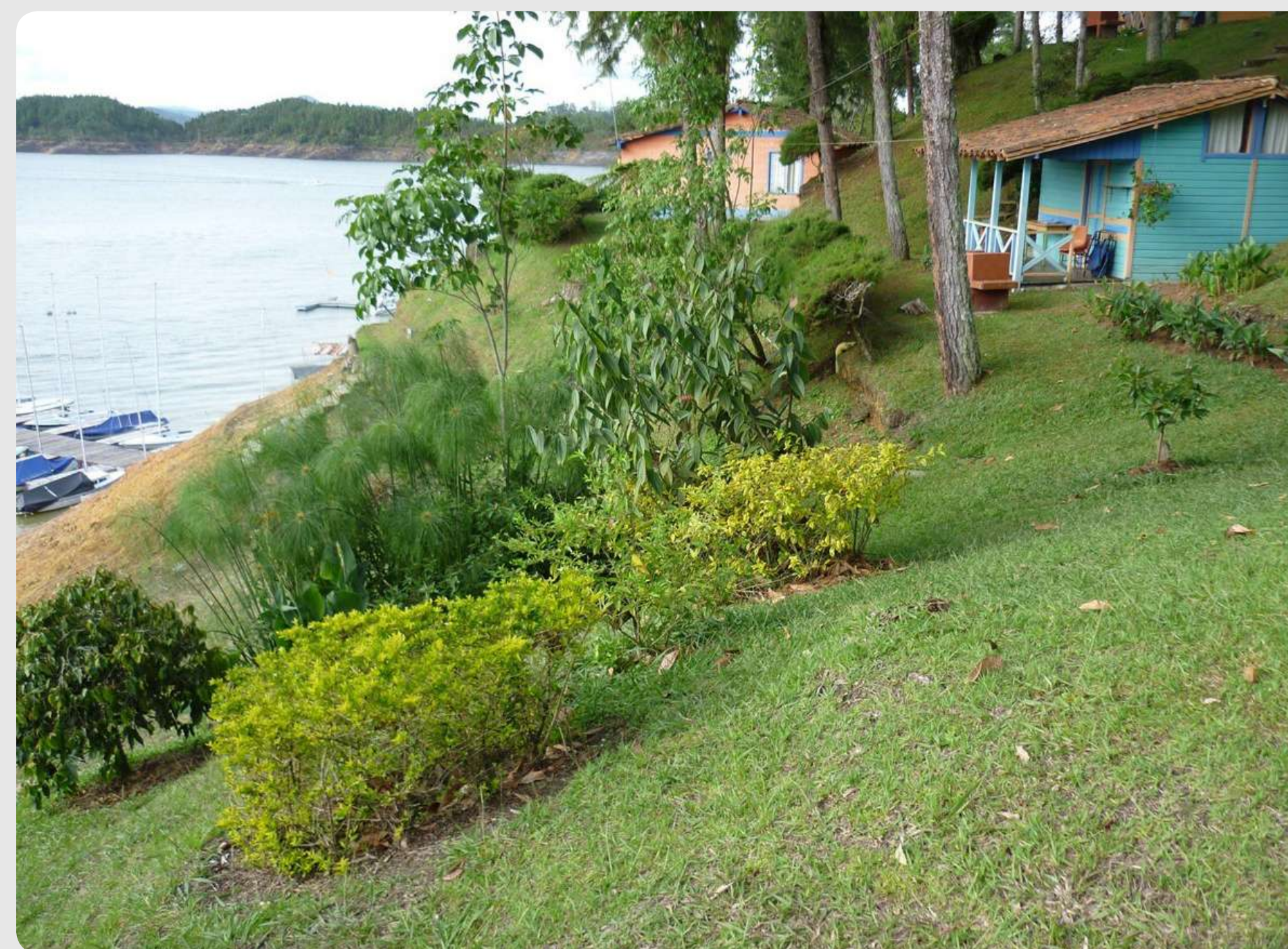
Figura 20. Humedal construido para el tratamiento de aguas residuales. Corporación Recreativa de Antioquia. Guatapé - Antioquia
