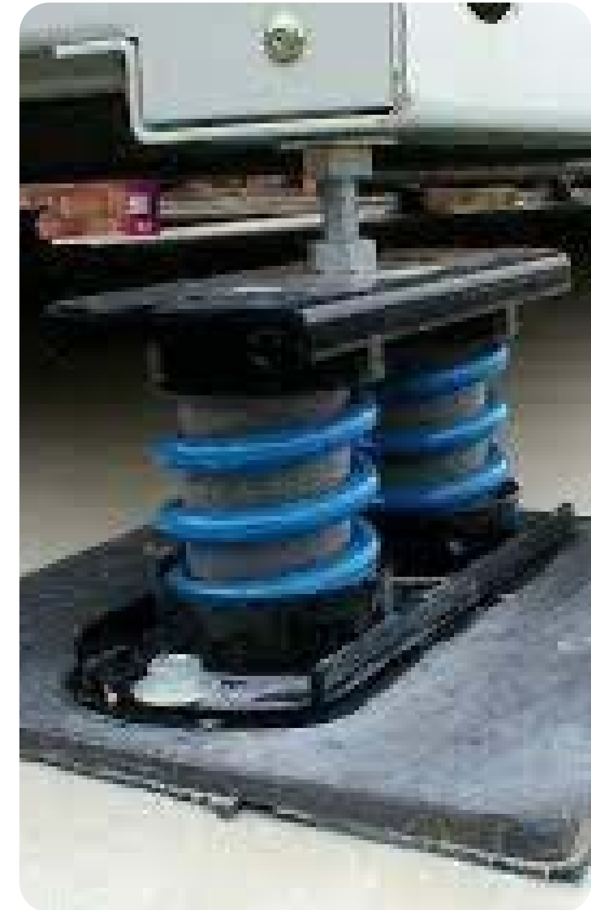
Figura 5. Ejemplo uso de sistema anti vibratorio
