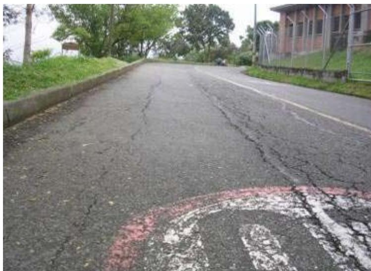
Figura 2.14 Hundimiento en la vía de acceso a la cima. Camino principal.
