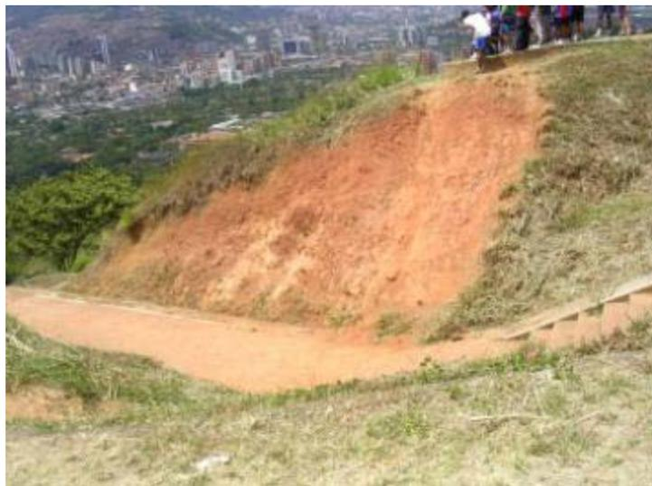
Figura 2.29 Talud erosionado Mirador de la Cima (Arqueológico)
