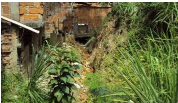
Figura 2.33 Invasión de retiros y taludes socavados Caño San Germán
