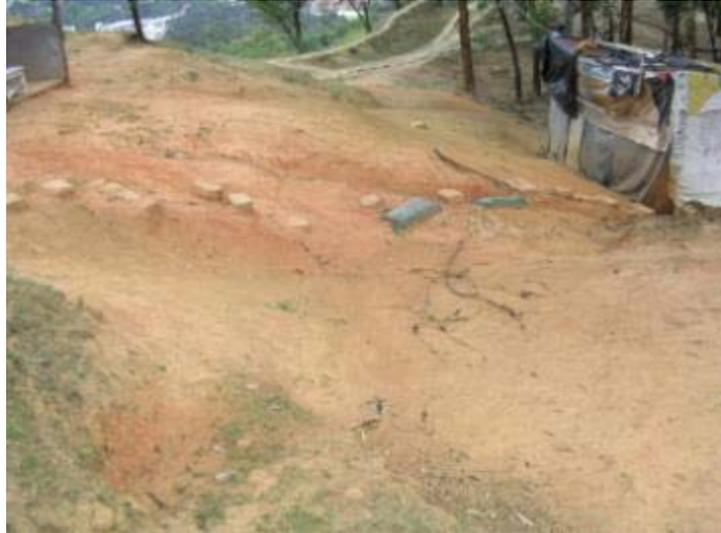
Figura 2.30 Talud erosionado Base Militar.
