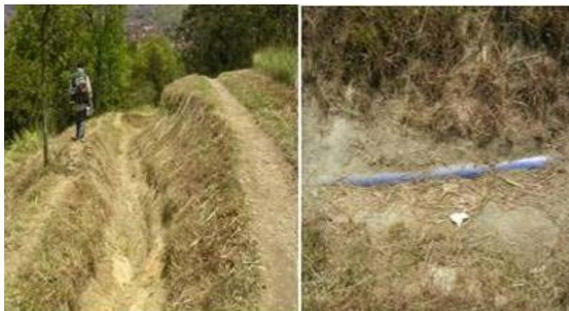
Figura 2.34 Afectaciones generadas por la circulación de caballos en Sendero Cometeros. Cárcava (izq.). Tubería expuesta (der.).
