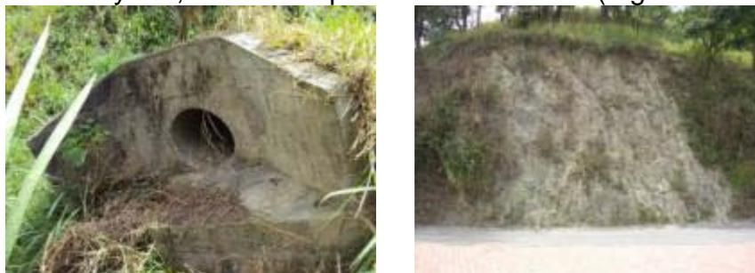
Figura 2.27 Desprendimiento de la Salida del Descole Caño San Germán (izq.) y Erosión taludes cercanos al Mirador Sur (der.).
