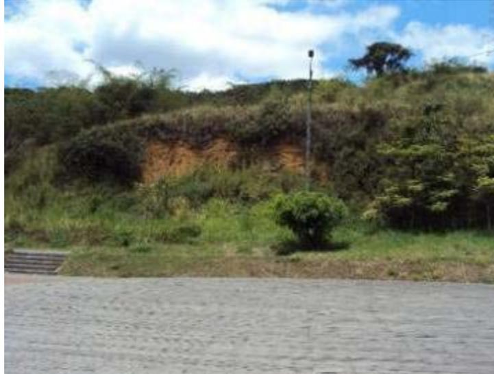
Figura 2.19 Erosión taludes plazoleta de ingreso Carrera 65.
