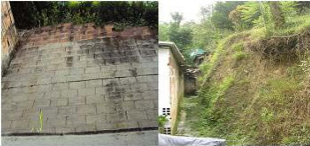
Figura 2.32a) Muro lindante con un talud afectado por agrietamientos y humedades (Izq.), b) talud aledaño a vivienda (der.)
