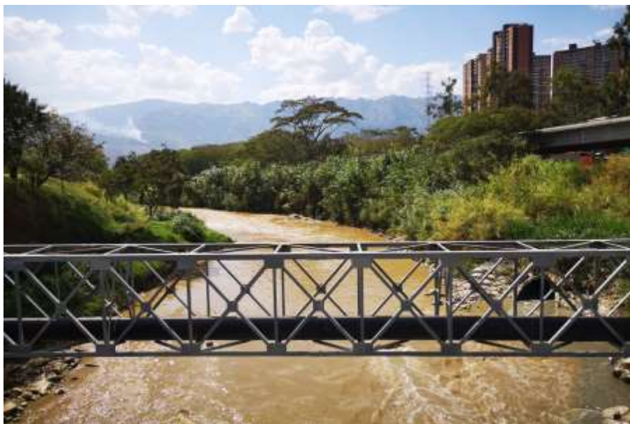
Foto 3. Bypass PTAR Aguas Claras
