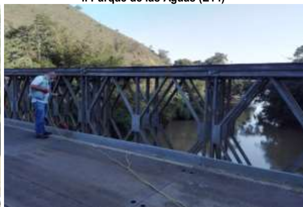
n. Puente Gabino (E20)
