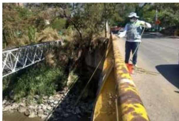
i. Puente Machado (E11)
