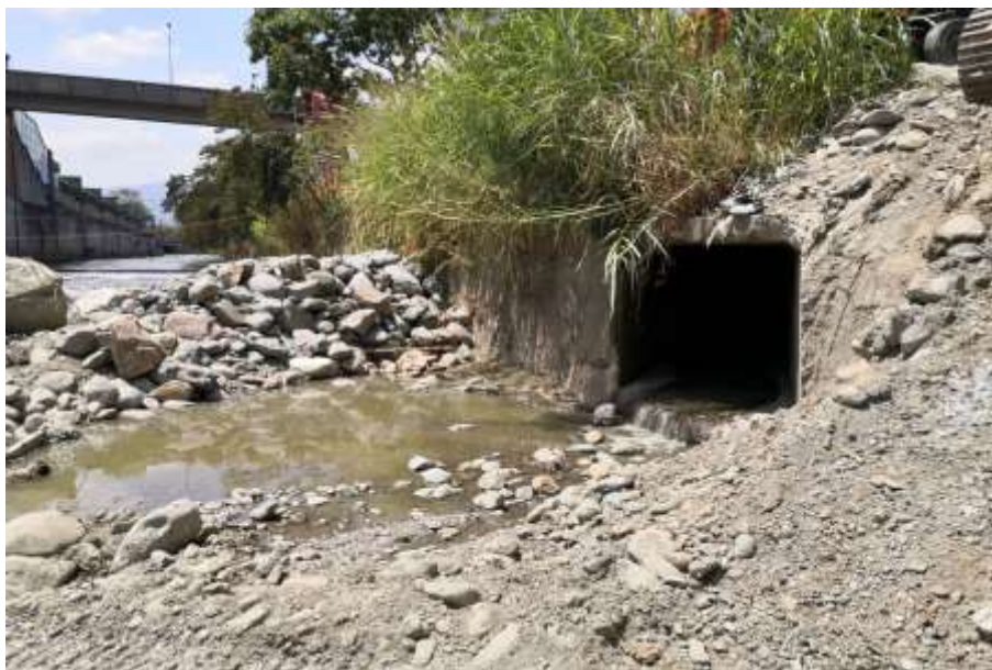
Foto 2. Descarga margen izquierda aguas abajo E5
