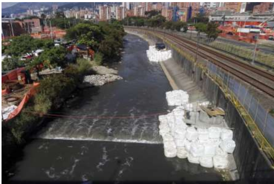
Foto 1. Invasión del cauce obras puente Ayurá
