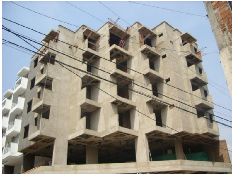
FOTOGRAFÍA 202. VIVIENDAS EN ALTURA, MUNICIPIO DE LA ESTRELLA. CUENCA DEL RÍO ABURRÁ 2016 ACTUALIZACIÓN POMCA RIO ABURRÁ, 2016
