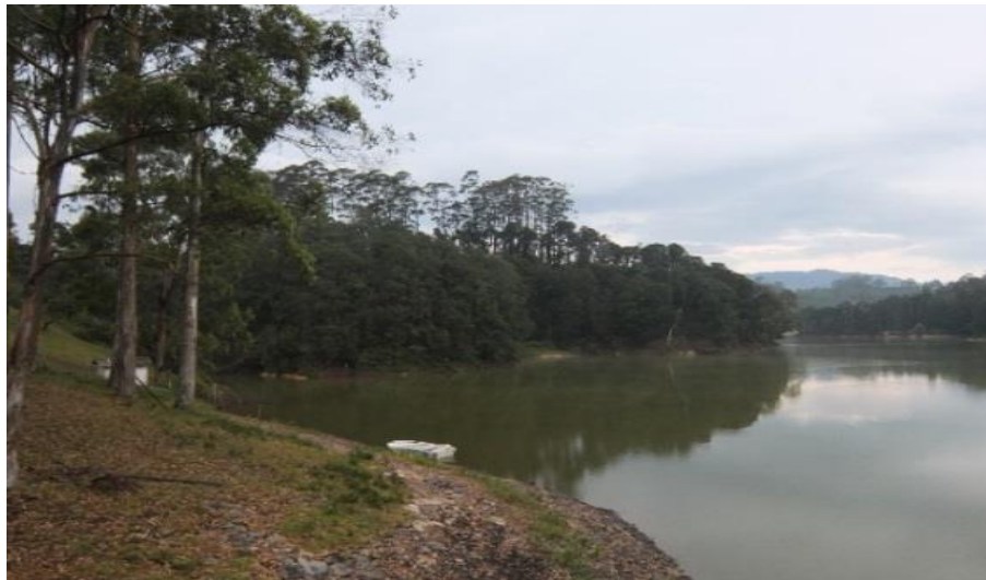
FOTOGRAFÍA 154. (A) EMBALSE LA GARCIA EN MUNICIPIO DE BELLO
