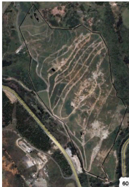
Figura 7.17 - Relleno sanitario de Curva de Rodas
