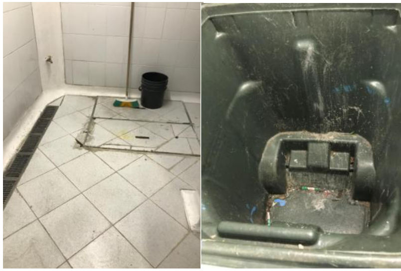
Imagen 9. Cuarto de almacenamiento final de residuos (Caneca de ordinarios - Estado del cuarto)
